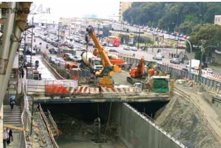
Veduta del primo lotto dei lavori di rifacimento della copertura del Bisagno presso la foce
